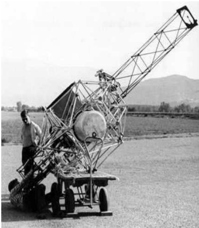
Figure 42 : L'une des premières expériences spatiales françaises : ce coronographe à occultation externe (on distingue en haut du tube le disque occulteur) sera lancé d'Aire sur Adour (CNES). Document Audouin Dollfus, Obs. Paris.
