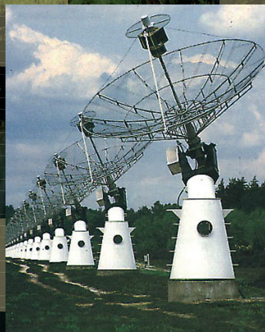
Radiohéliographe de Nançay, observant les rayonnements des particules dans le domaine radio électrique (ondes métriques). © OBSERVATOIRE DE PARIS
