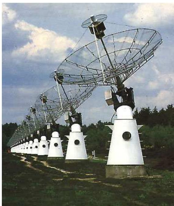
Figure 41 : Le Radiobéliographe de Nançay est un interféromètre à antennes multiples qui fournit aux chercheurs des images du Soleil en ondes radio métriques (document Obs. Paris). Chaque ligne de base mesure de l'ordre du kilomètre et porte plus de 20 antennes.
